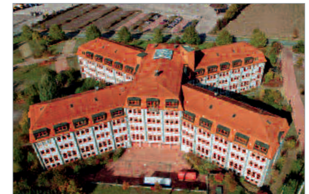
Verwaltungsgebäude in Weismain
